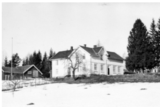
Holtung skole slik den ble etter ombyggingen.
