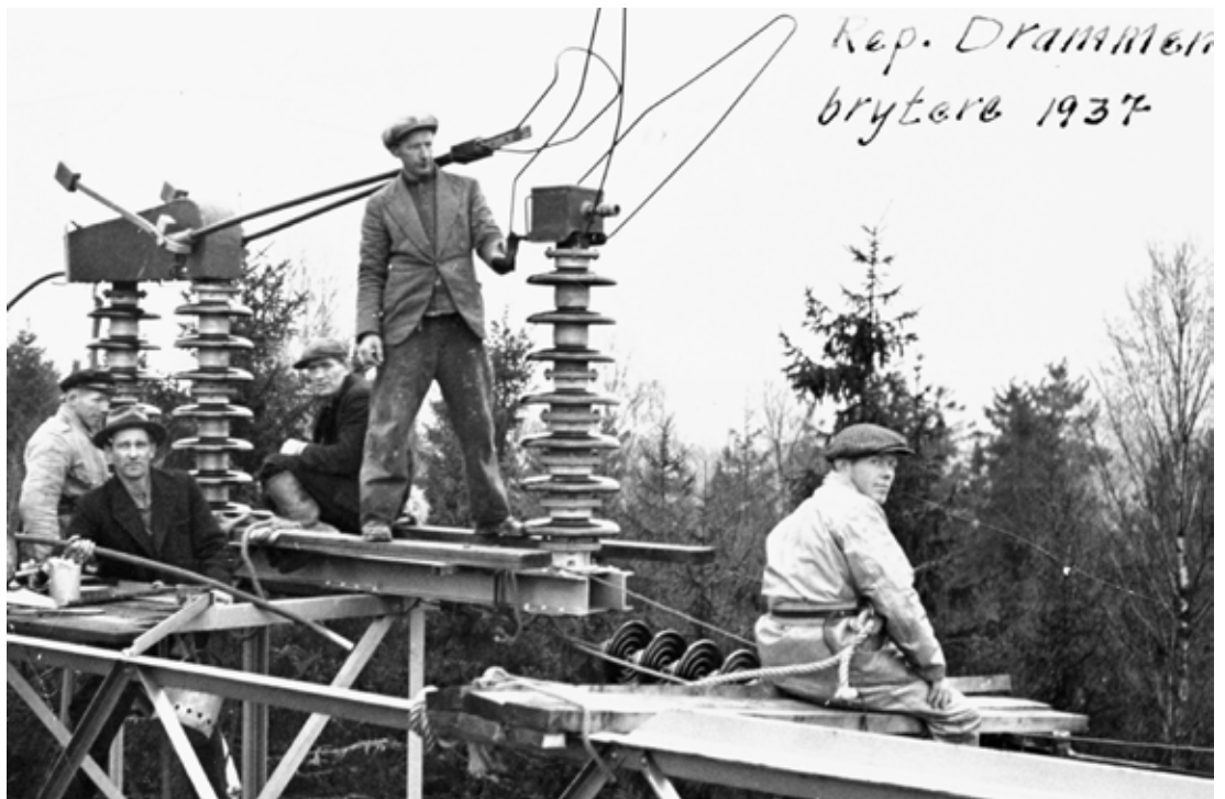
Reparasjonsarbeid på Huseby omkoblings- og transformatorstasjon. Fra venstre: Hans O. Helstad, Lars Johan Lefsaker, Lars Bugge Haugtuft og Paul Kristian Lefsaker. Foto hentet fra bildesamlingen til Våle historielag.
