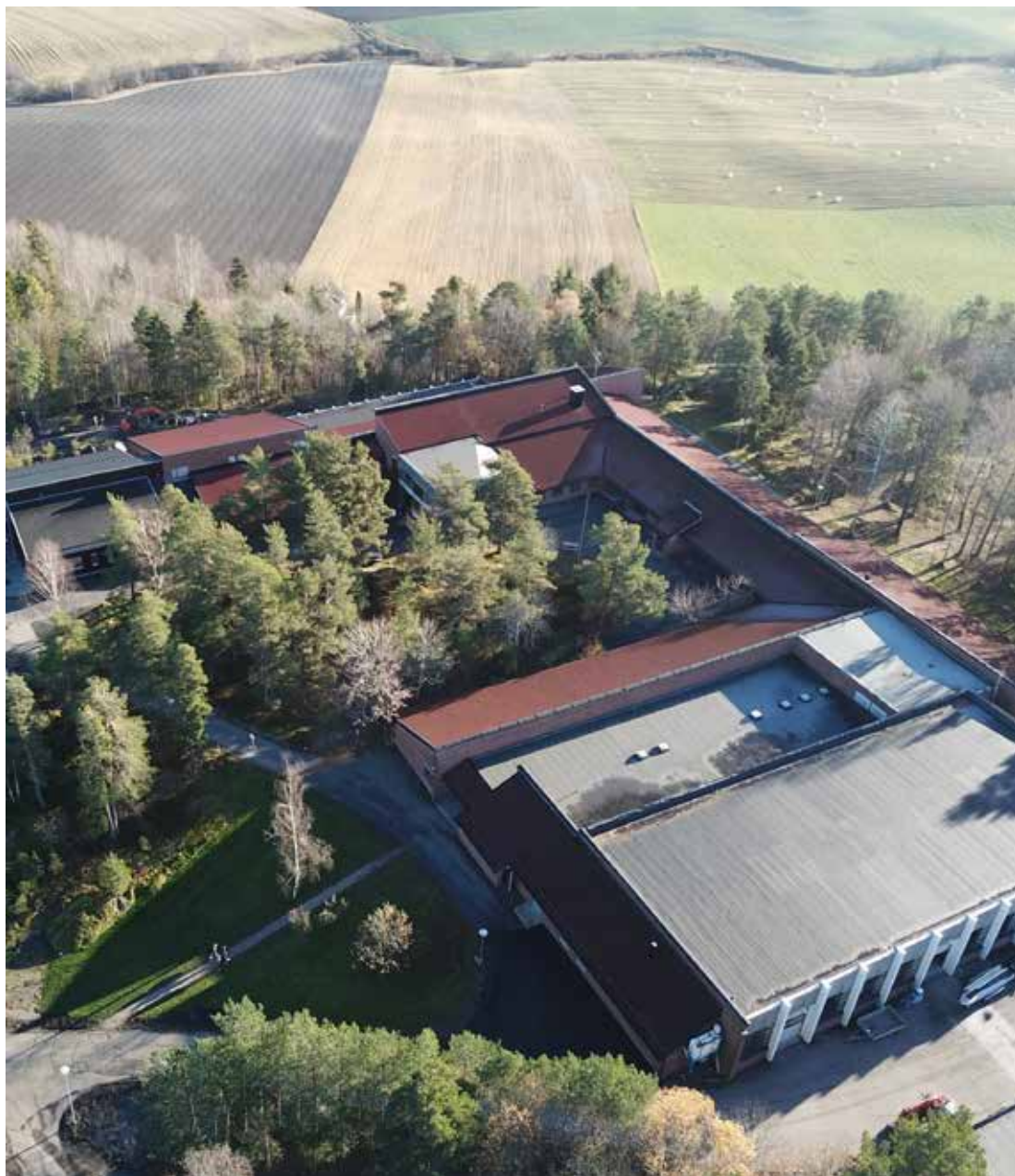
Høyt på Bergsåsen troner Re vidaregående skole med en omfattende bygningsmasse. I tillegg er bygningene omgitt av utendørs idrettsanlegg, som ikke kommer med på dette bildet. Foto: Eivind Ellingsen.
